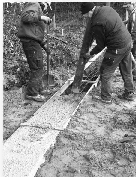
li: Vergangenheitsbewältigung Bauschutt<sup>2</sup>, re: Ringfundament wird geschüttet<sup>2</sup>
