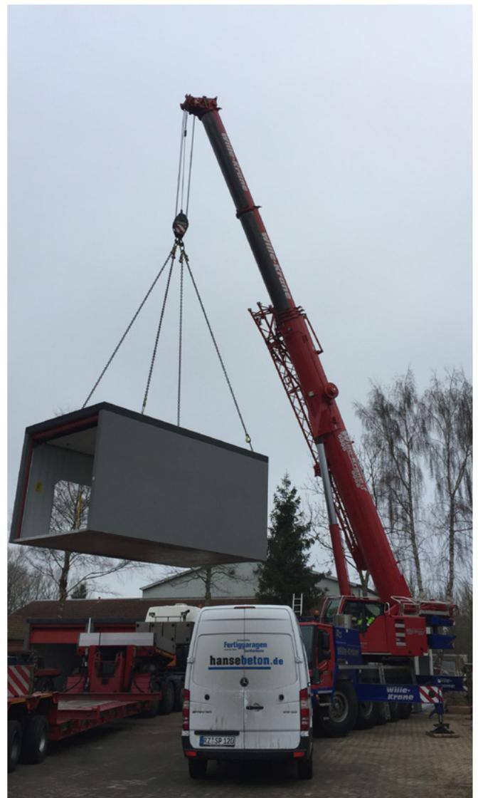
Schwerlastkräne positionieren die Fertiggroßgaragen am 24.01.2017.
